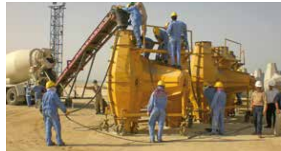
Bétonnage avec tapis roulant
