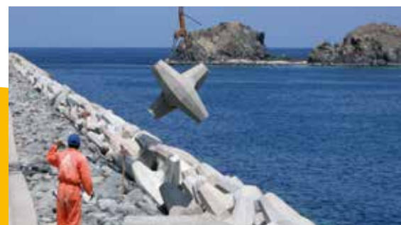
Pose d'un bloc CORE-LOC™
