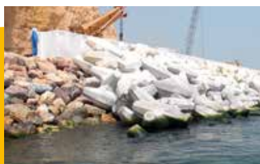
Carapace en cours de pose
