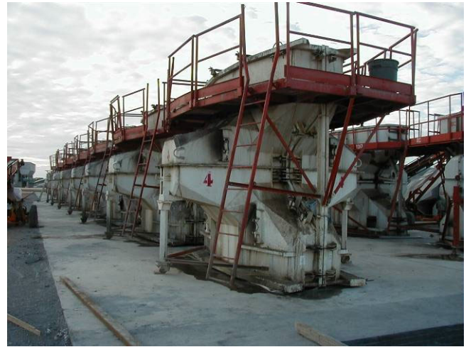
Photo No. 5: Coffrages prêts pour assemblage
