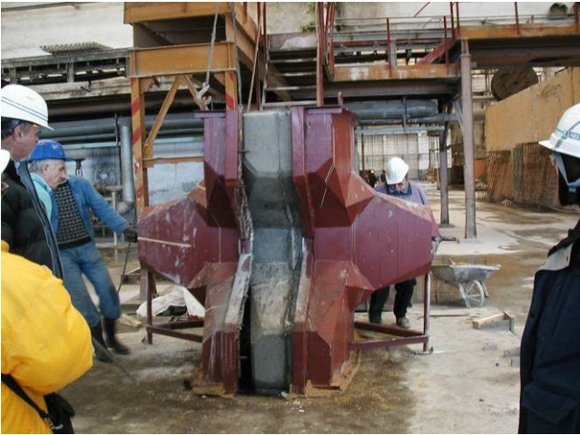
Photo No. 4: Décoffrage
