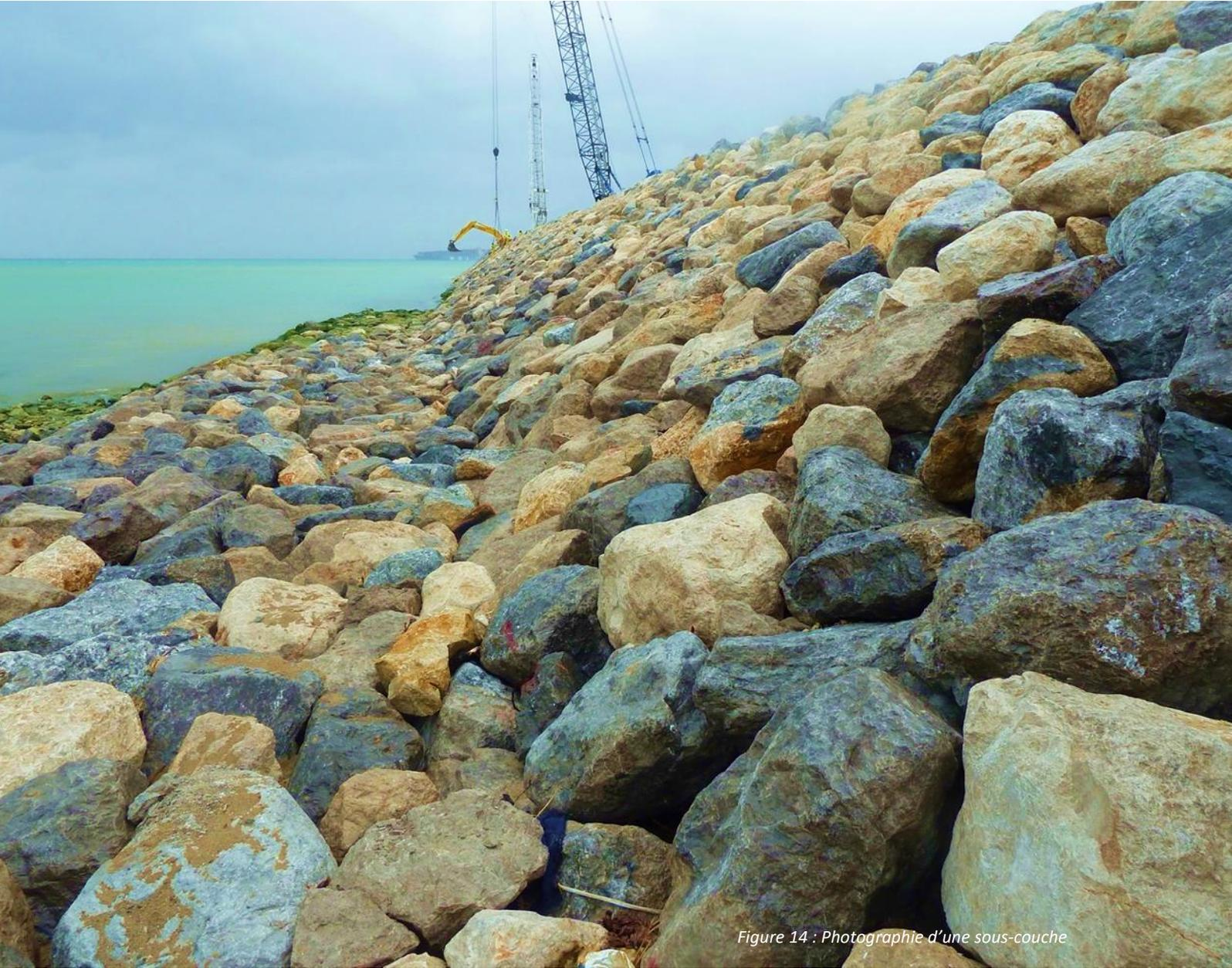
Figure 14 : Photographie d'une sous-couche
