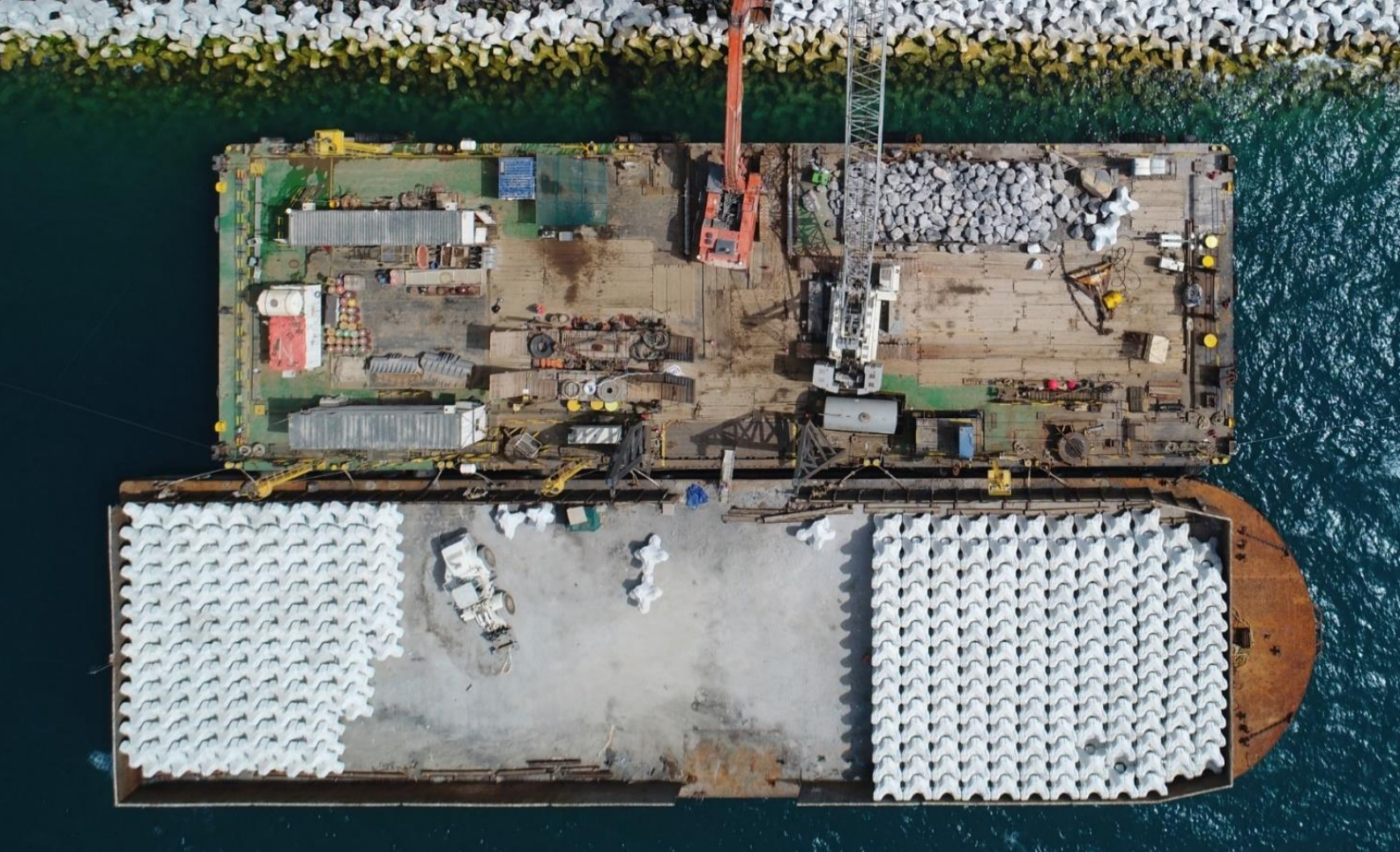
Figure 10 : photographie de mise en place de blocs ACCROPODE™ à la grue sur barge
