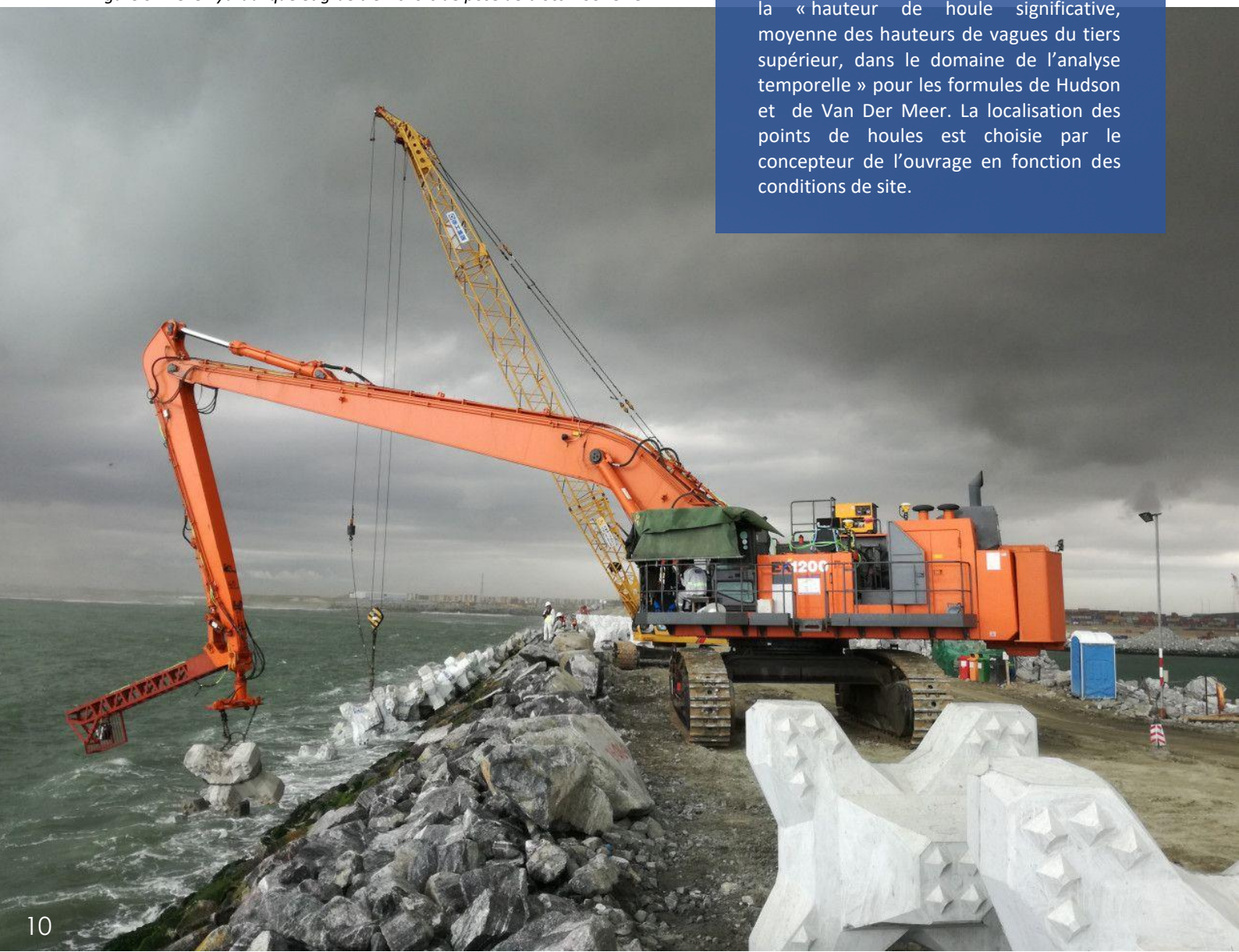
Figure 5 : Pelle hydraulique et grue treillis lors de pose de blocs ACCROPODE™ II
