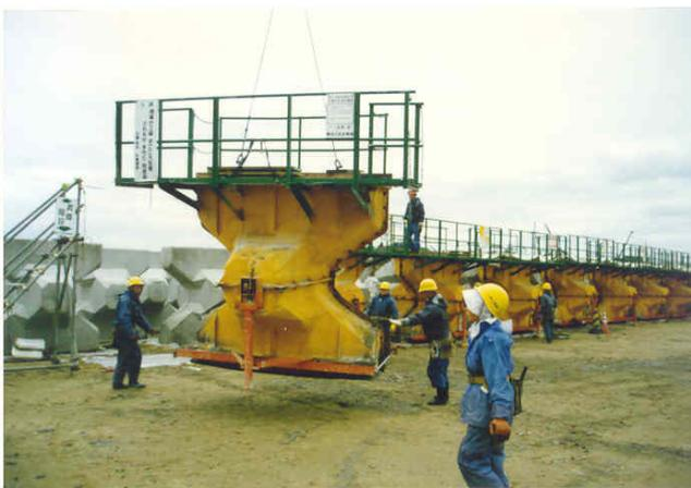
Photo No. 2: Déplacement d'un coffrage
