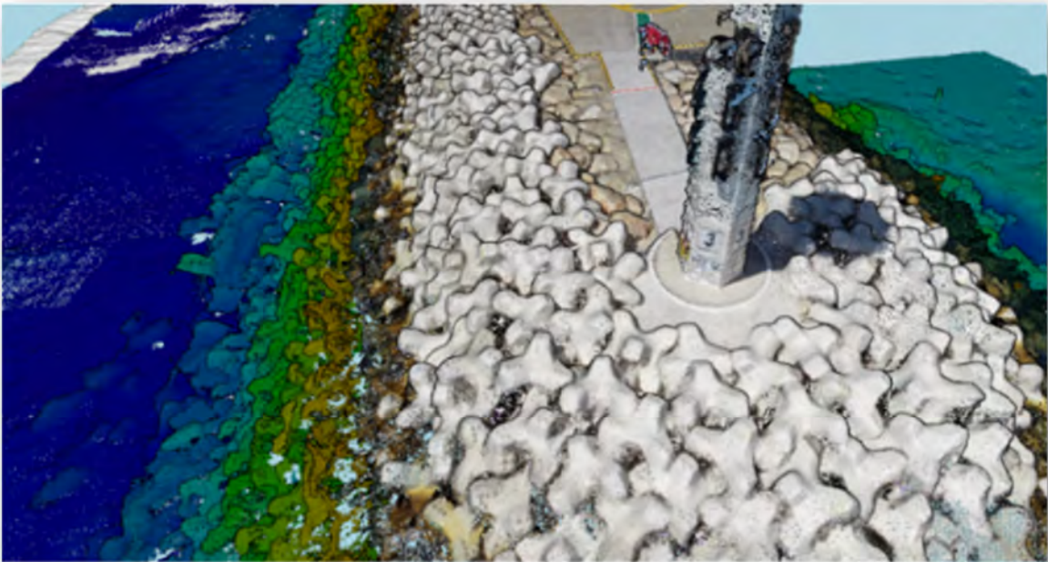
Exemple de drone balayant la digue
