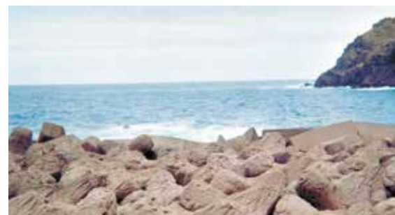
ECOPODE™ en crête d'ouvrage
