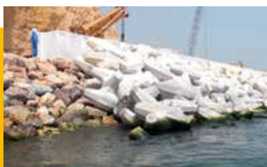
Carapace en cours de pose
