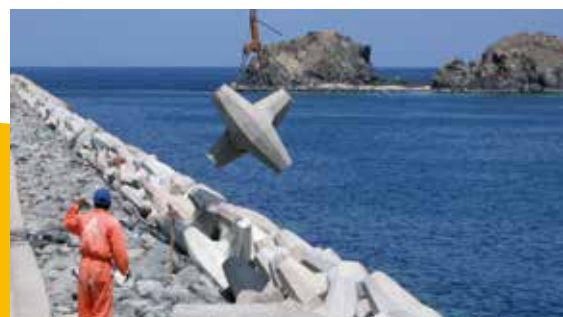
Pose d'un bloc CORE-LOC™
