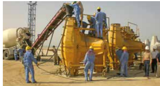
Bétonnage avec tapis roulant
