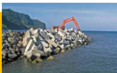
Vue de profil à l'avancement de la pose
