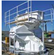
Moule prêt au bétonnage
