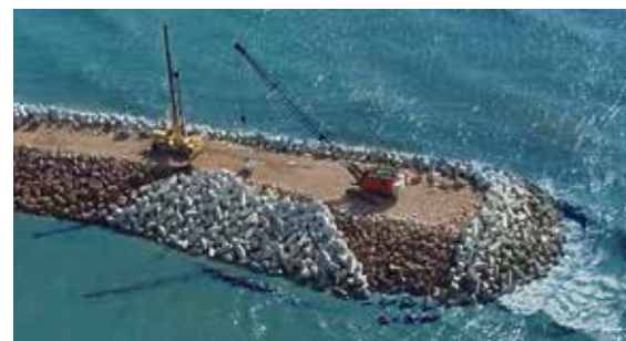
Carapaces en cours de pose
