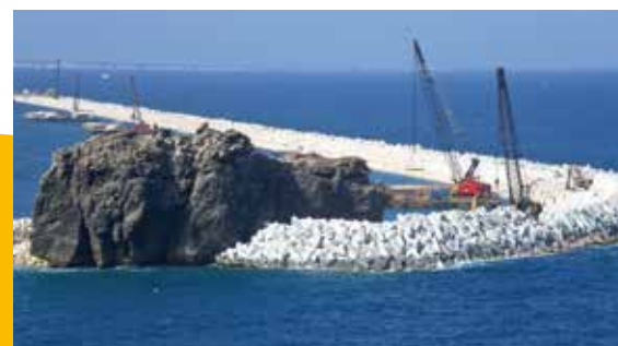
En cours de finition
