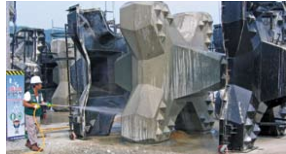
Opération de démoulage
