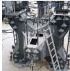
Moule prêt pour le bétonnage
