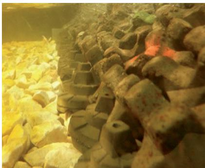
**L'ACCROBERM™ II** est une option économiquement viable lorsque les enrochements de contre butée doivent être excessivement lourds ou lorsque l'intérêt éco-conception est plus prégnant.
