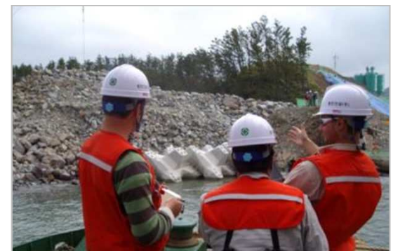
Assistance à l'entreprise sur le chantier
