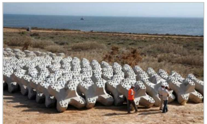
Stockage des blocs ACCROPODE™ II
