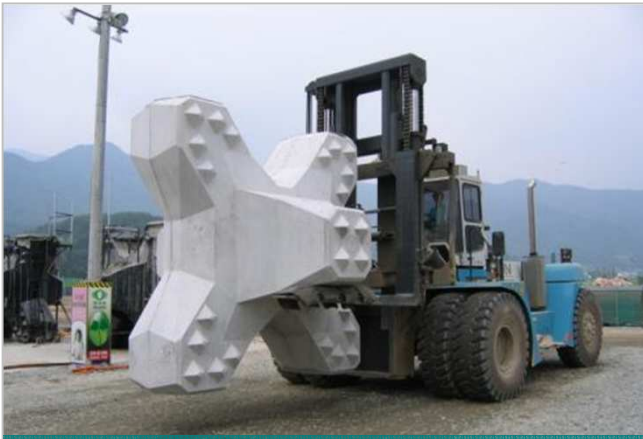
Transport par chariot élévateur d'un bloc de 11 m 3
