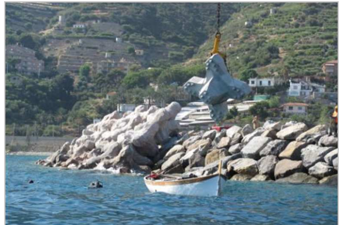
Pose des blocs ACCROPODE™ II unit
