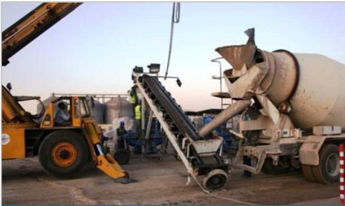
Coulage du béton
