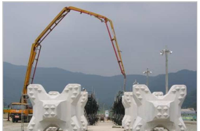
Coulage de bloc
