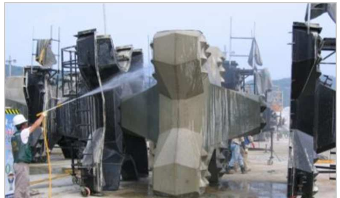
Produit de cure projeté su un bloc fraîchement fabriqué
