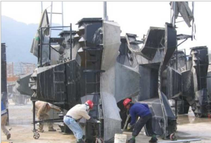
Décoffrage du bloc
