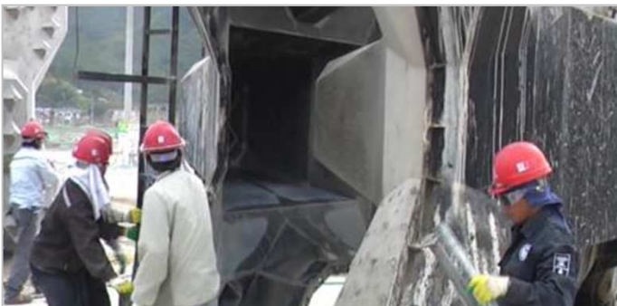
Ouverture d'un coffrage de 20m 3
