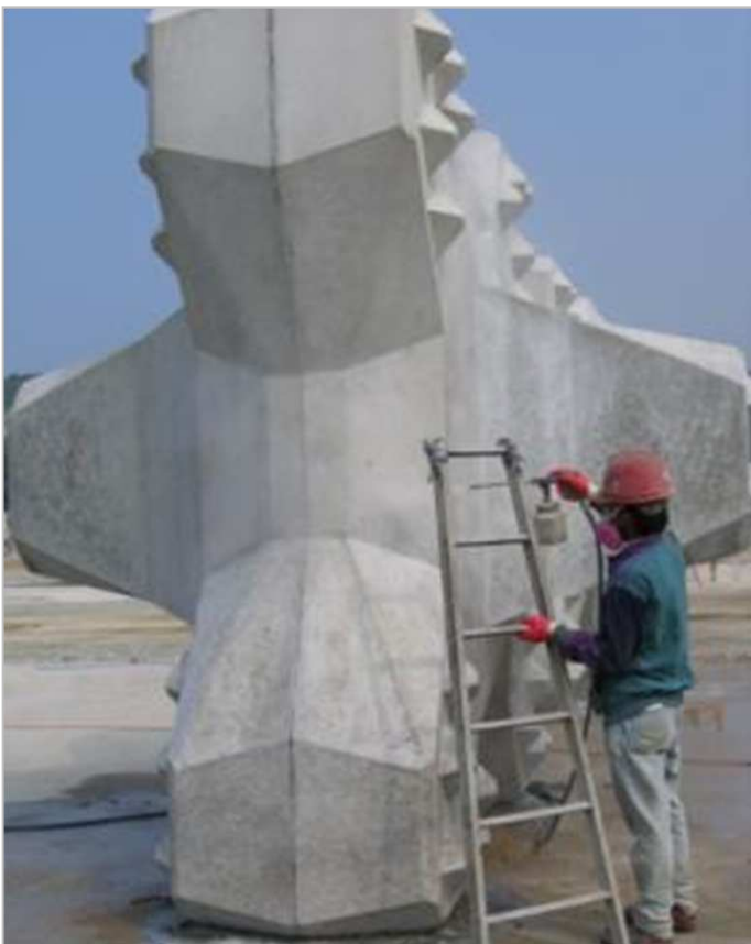
Projection d'un produit de cure
