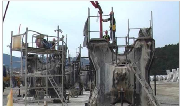
Mise en place du béton dans le moule
