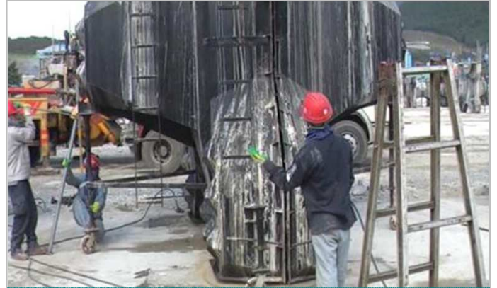
Mise en place du moule
