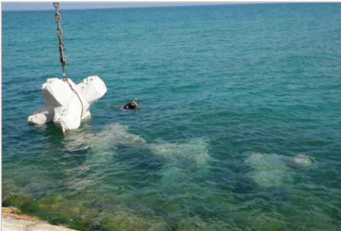
Pose des blocs ACCROPODE™ II unit
